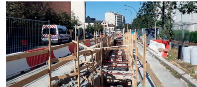
Aubervilliers, rue du Commandant L'Herminier
